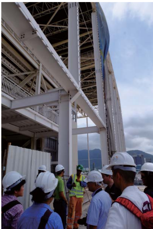
工事中の会場を見回る日本視察団
